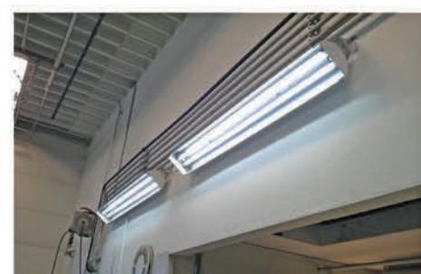
Серията LUMINO са тела за луминесцентни лампи с прозрачен призматичен разсейвател и с ключ. Съвместими са със стандартните T5 луминесцентни лампи. Предлагат се в комплект с лампа с неутрална 4200K, захранващ и свързващ кабел, аксесоари за монтаж на стена или под кухненски шкаф.
